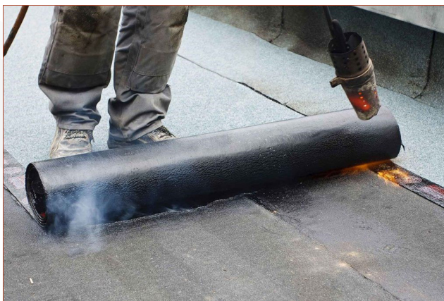
شکل ۱- ایزوگام جهت عایق‌بندی رطوبتی سطوح
