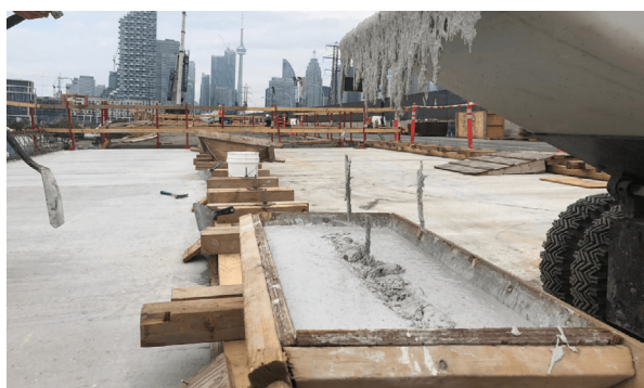
شکل ۳- نحوه ساخت سازه‌ها با استفاده از بتن داکتال
