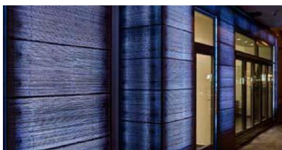
شکل ۷- استفاده از بتن شفاف در آلمان
