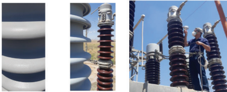
شکل ۳۴- عملیات پوشش‌دهی مقره‌ها (سمت راست) و مقره‌های پوشش داده شده و بکناختی پوشش‌دهی سطحی آن‌ها
