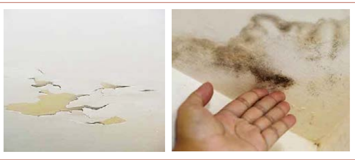
➤ شکل ۴. نفوذ آب و رطوبت به داخل گچ باعث ایجاد پوسته شدن و ظاهر نامناسب گچ می شود.
