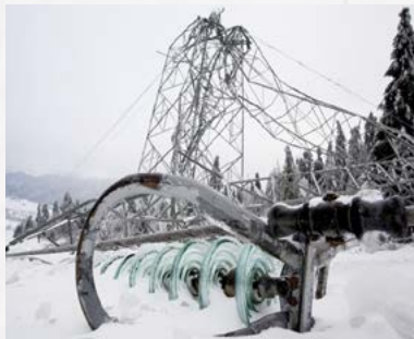
➤ شکل ۸. ویرانی استراکچر به دلیل کمبود استقامت مکانیکی
