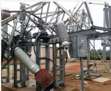
➤ شکل ۸. ویرانی استراکچر به دلیل کمبود استقامت مکانیکی
