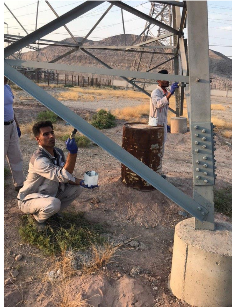
دکل گالوانیزه انتقال نیرو پوشش داده شده در بندرعباس پس از ۱ سال
