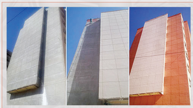
شکل ۸. سطوح عایق کاری شده با رنگ‌های عایق رطوبت.
