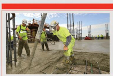
■ **کف‌سازی طبقات:** کف‌سازی طبقات از مهم ترین و وسیع ترین کاربردهای بتن سبک است. با جایگزینی بتن سبک به جای پوکه معدنی حدود ۳۰ کیلوگرم سبک‌سازی در هر مترمربع صورت می‌گیرد. همچنین با استفاده از این بتن سه برابر عایق‌بندی حرارتی و صوتی بیشتر در کف طبقات صورت می‌پذیرد.
