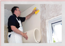
▲ استفاده از آئروژل پتویی برای عایق کاری دیوارها
