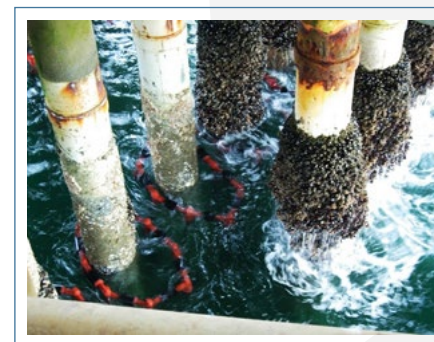
شکل ۳. رسوبات تشکیل شده روی پایه های سکوی نفتی
