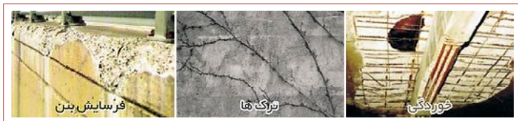
شکل ۱. نمونه های از بروز مشکلات در مصالح ساختمانی به دلیل وجود آب و رطوبت
