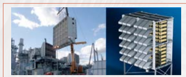
شکل ۱. قسمت سامانه فیلتراسیون در ورودی هوای توربین گازی ۱۱.
